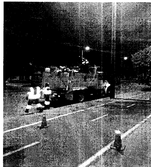
Fotografía 16. Intervención de Área Limpia S.A. E.S.P.
